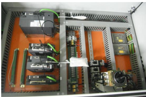
ภาพที่ 1.5 ภายในของชุดคอลโทรลเลอร์ (ที่มา : ฤกษ์ณพล เรื่องไฟศาล โปรแกรมเอ็นซีพื้นฐาน. 2563)
